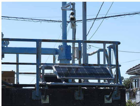
水門への取付
